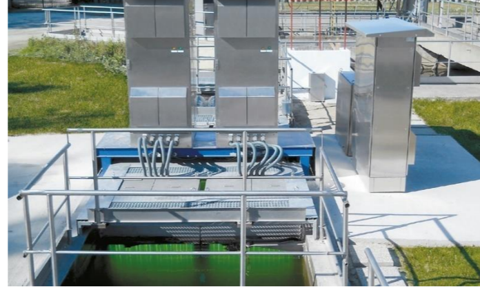
Очистка сточных вод
